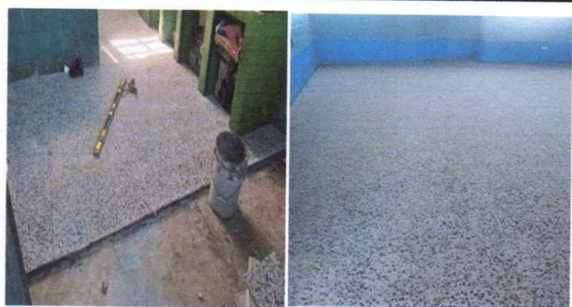
Foto 3: Colocando piso granito
