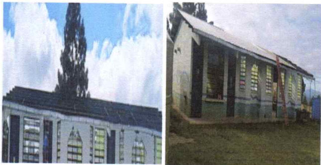
Foto1: Instalando techo de lámina.
