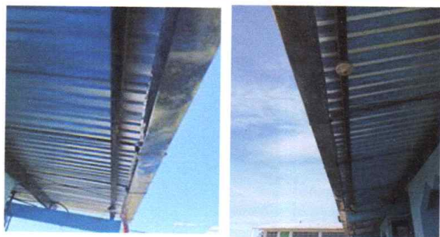
Foto 4: Instalando canales de agua pluvial
